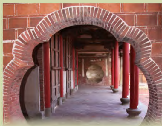
發卷施工技法劍環門
